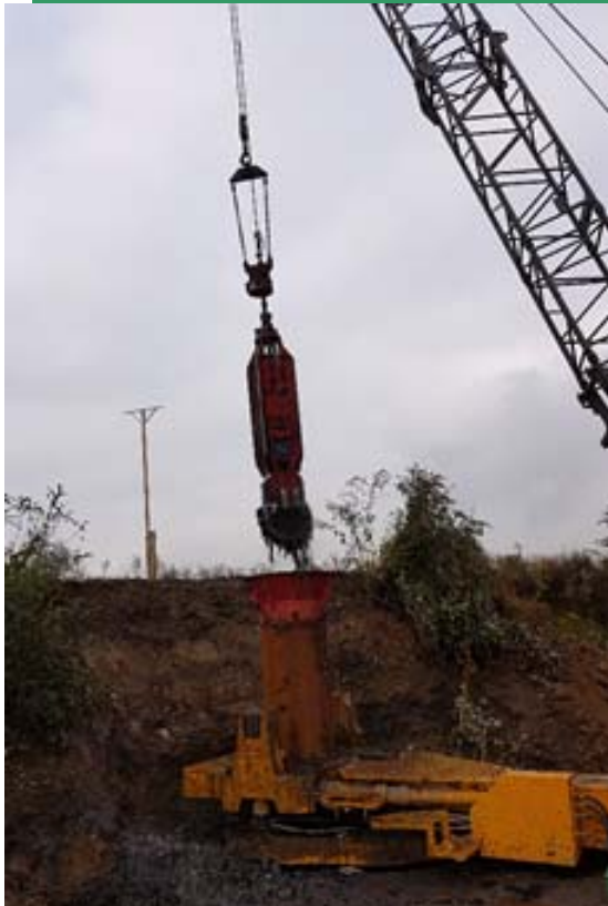
Bauausführung der neuen GB, Firma Hölscher
